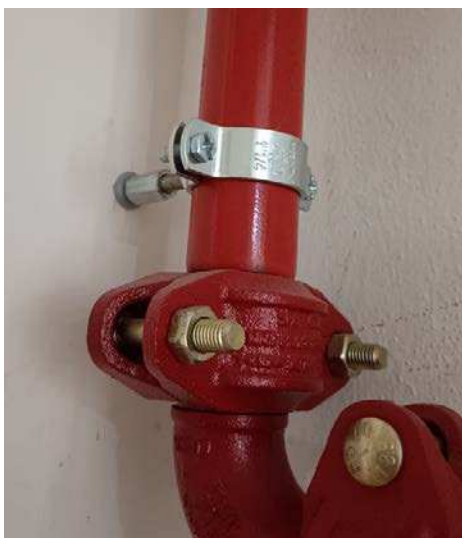
STAFFAGGIO STATICO+GIUNTO RIGIDO
